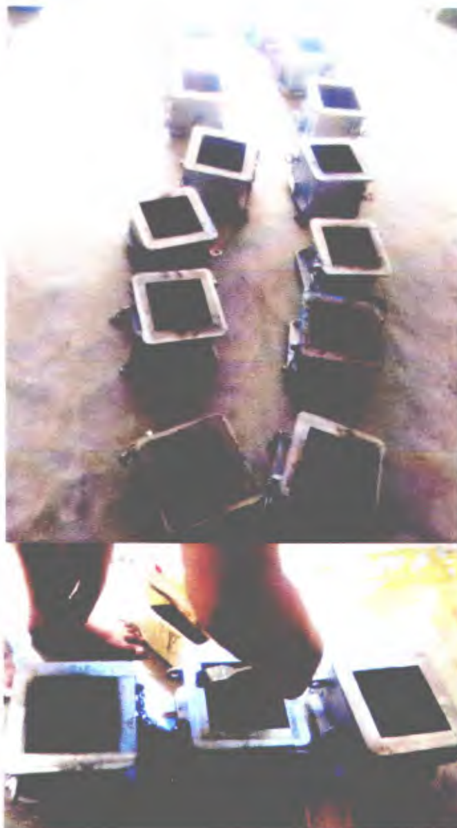
ภาพที่ 3.3 เตรียมแบบหล่อคอนกรีต
