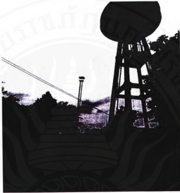
ภาพที่ ผ.1 ก ประปาหมู่บ้าน บ้านควนป้อม หมู่ที่ 1
