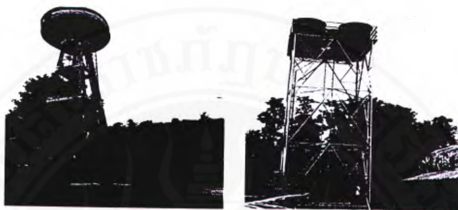
ภาพที่ 4.15 แสดงลักษณะของหอดึงสูงจ่ายน้ำประปาหมู่บ้าน
